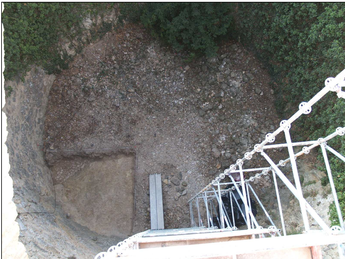
Vista del interior de la cava durante el proceso de excavación.
