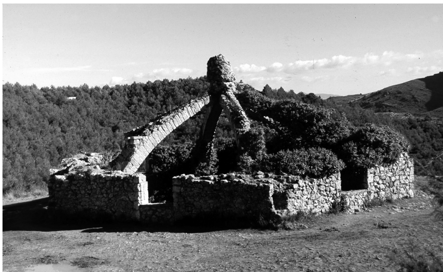
8. La Cava Gran (Agres) en la sierra de Mariola. En 2005 se eliminó la hiedra que cubría peligrosamente gran parte del pozo y de los arcos.
